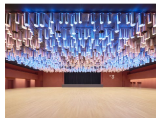
BU: Das Planungsteam rüstete den Saal 3 mit energieeffizienter LED-Technik aus und konnte die charakteristische Kannenleuchtendecke erhalten.
