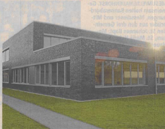
Mit dem grauen Klinker haben die Technischen Schulen des Kreises in Steinfurt nach ihrer Sanierung eine neue markante Fassade erhalten.
