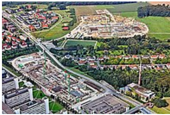
Voll im Rohbau | FOTO: SUSANNE FREITAG
